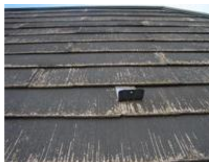
反り返しのため隙間が生じる
